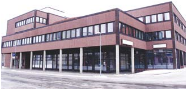
Politihuset i Namsos som eksempel på hvordan ulike elementer av ulike proporsjoner i en fasade står sammen.
