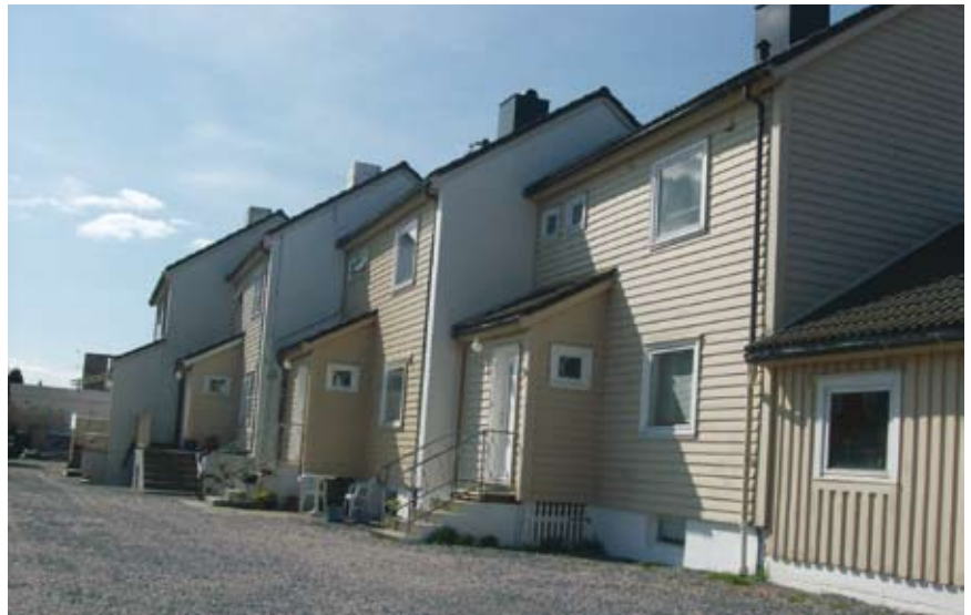
Rekkehus på Trones, Sandnes. Typiske rekkehus fra perioden 1950-1960. Se også likheter med bildet ovenfor og bildet nedenfor.
